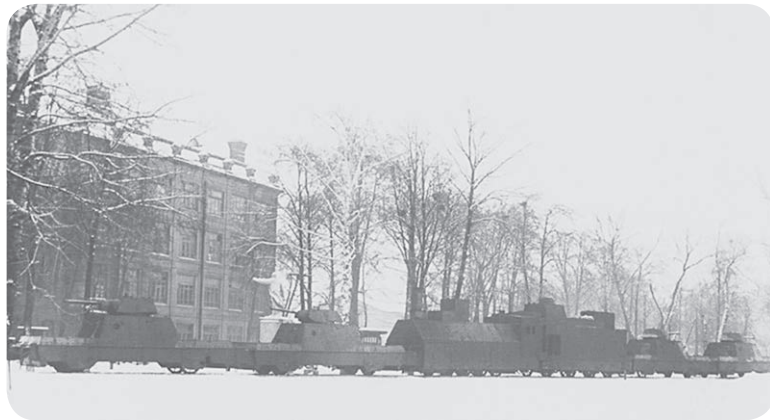
Первый бронепоезд типа БП-43, изготовленный на Коломенском машиностроительном заводе в декабре 1942-го года. В центре бронепаровоз, по бокам 4 бронеплощадки с башнями от танков разных модификаций.
